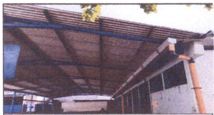
Sustitución de bajada de agua pluvial de metal por tubo pvc de 3" aulas módulo III
