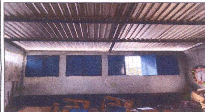
Instalación de ventanas de metal aulas, módulo II
