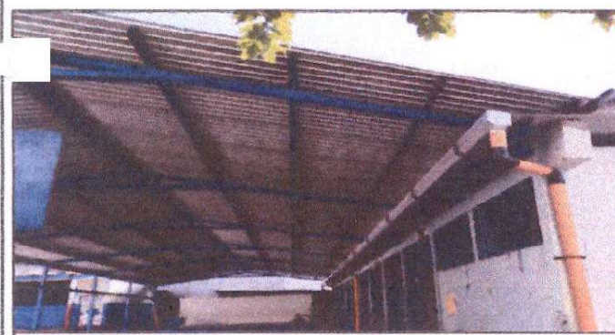
Sustitución de canal de metal aulas módulo III
