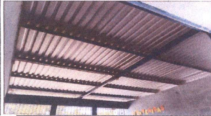
Sustitución de lámina, por lámina troquelada calibre 26 aulas módulo I
