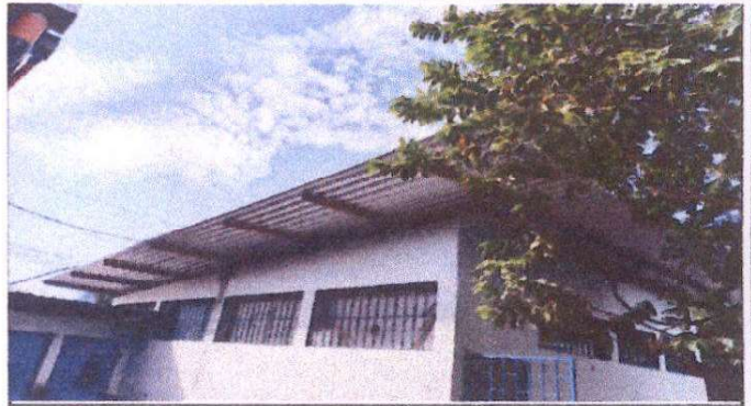
Sustitución de lámina, por lámina troquelada aluzinc calibre 26, aulas módulo II
