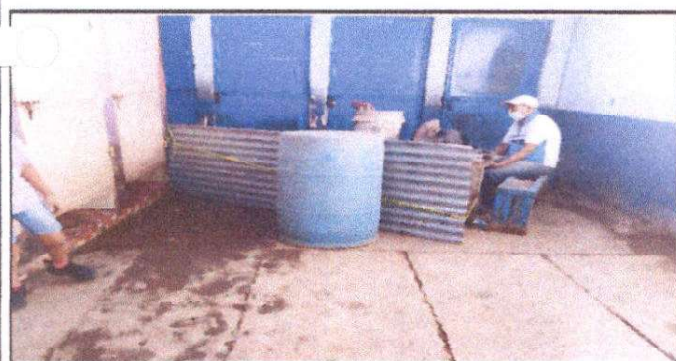
Sustitución de caja de registro
