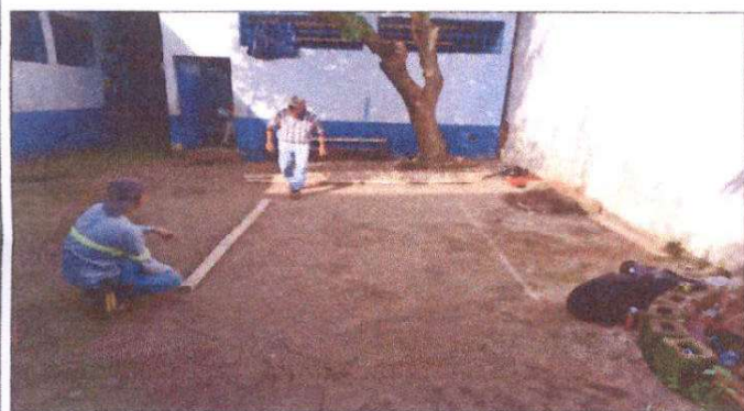
Instalación de depósito de concreto para agua
