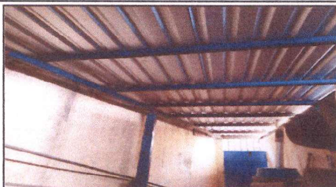
Reparación de Filtración de agua en cocina
