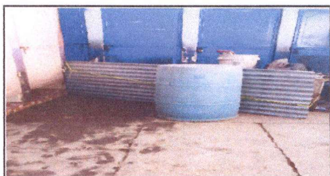
Sustitución de tubería de PVC de 3" para drenaje
