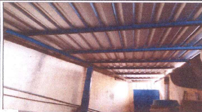
Reparación de lámina en cocina
