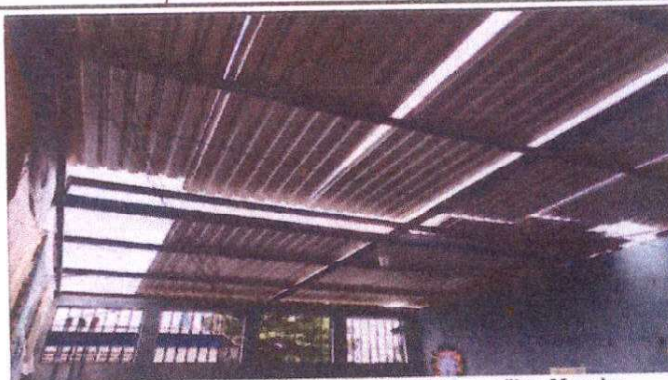
Sustitución de lámina, por lámina troquelada aluzinc calibre 26, aulas módulo II
