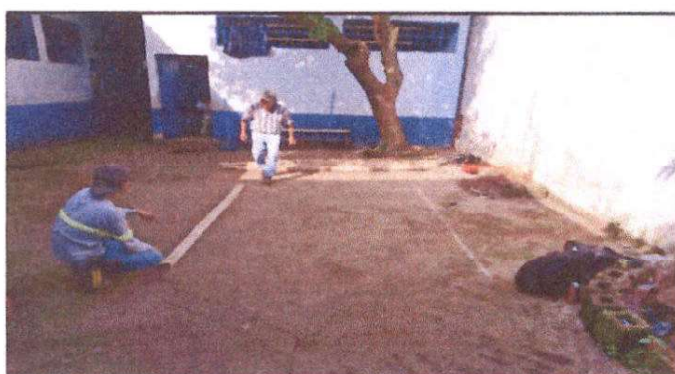
Sustitución de tubería línea principal
