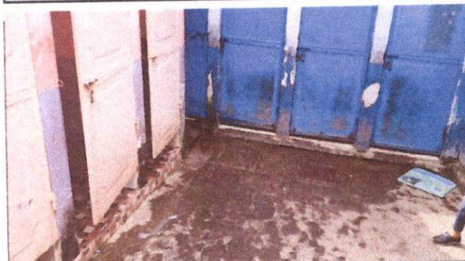
Sustitución de tubería de PVC de 3" para drenaje
