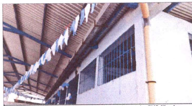
Sustitución de bajada de agua pluvial de metal por tubo PVC 3" aulas, modulo III
