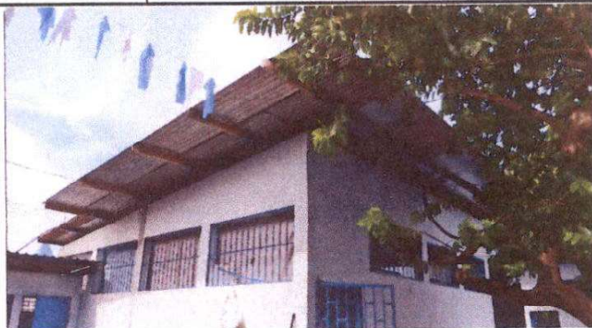
Sustitución de lámina, por lámina troquelada aluzinc calibre 26 aulas, modulo II
