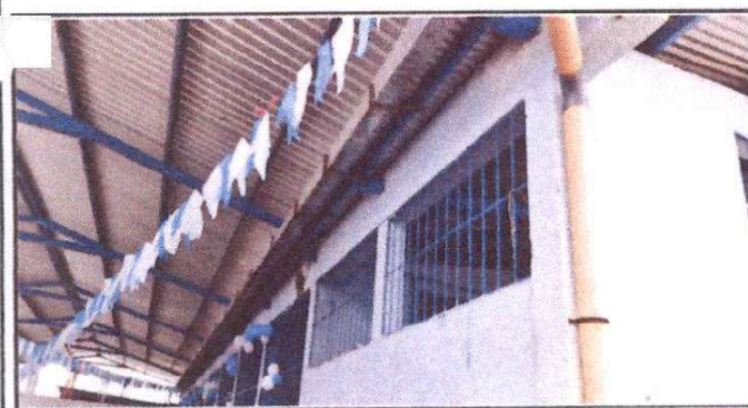
Sustitución de canal de metal aulas modulo III
