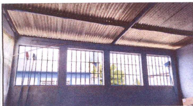
Instalacion de ventanas de metal aulas, modulo II
