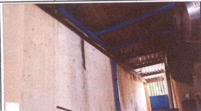
Sustitución de lámina en cocina
