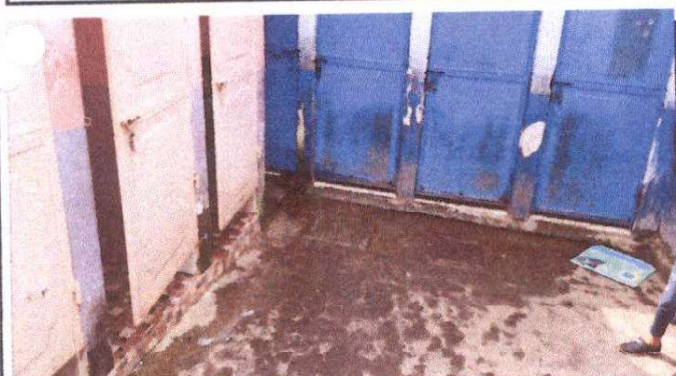
Sustitución de caja de registro
