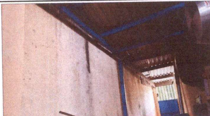
Reparación de filtración de agua en cocina
