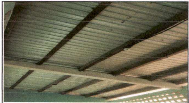
Foto 2. Sustitución de lámina troquelada
