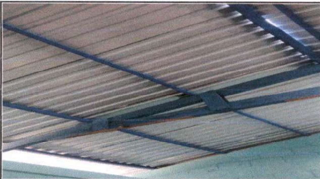
Foto 3: Salón tres, sustitución de laminas troqueladas y tendales.
