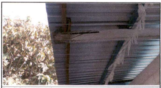
Foto 6: Colocación de focos con apagadores y cableado eléctrico.
