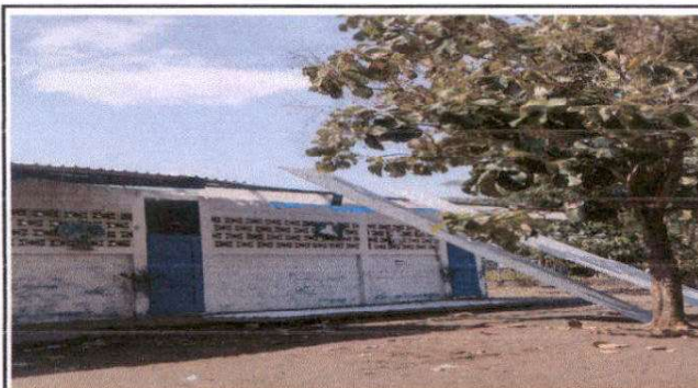
Foto 3. Colocación de lamina troquelada
