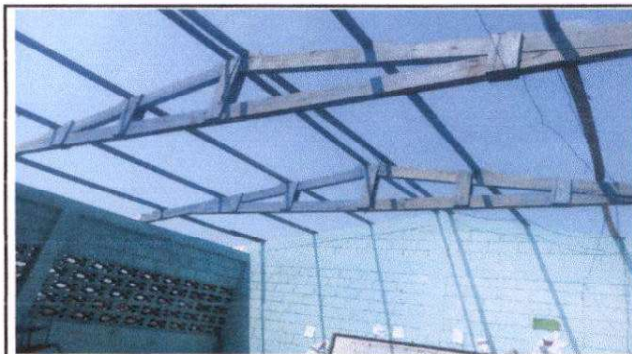
Foto 4. Desmontaje y colocación de reglas de madera.
