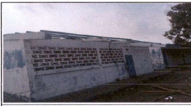
Foto 5. Desmontaje de laminas
