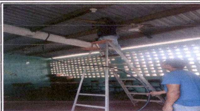
Foto 1. Instalación de sistema eléctrico.
