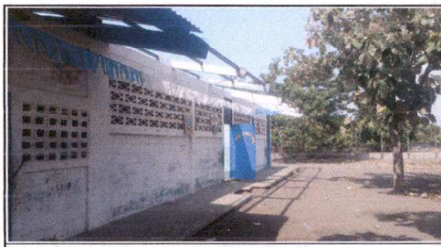
Foto 6. Colocación de lamina troquelada calibre 26.
