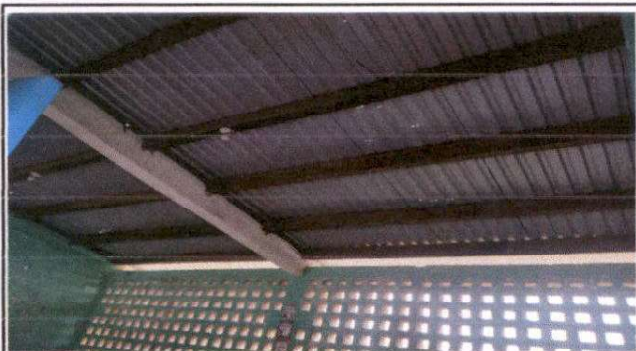
Foto: Salón uno, sustitución de láminas y tendales.
