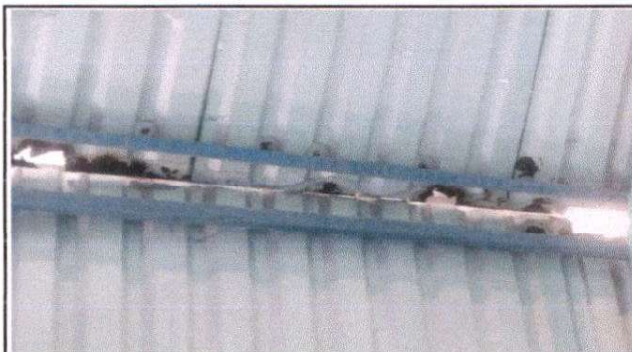
Foto 4: Salón cuatro, sustitución de láminas troqueladas y tendales.
