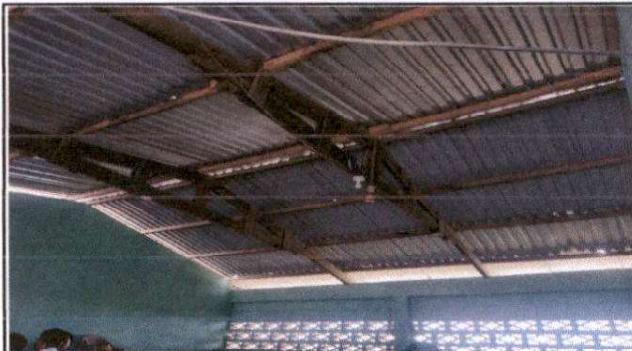
Foto 2: Salón dos, sustitución de laminas y tendales.
