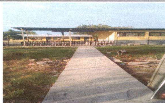
Foto 4: Cambio de camino de adoquin por concreto de la cocina hacia los salones.
