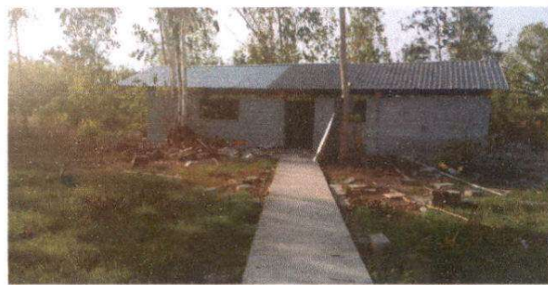
Foto 2: Expansión de cocina, remodelación, pila de concreto, estufa mejorada.
