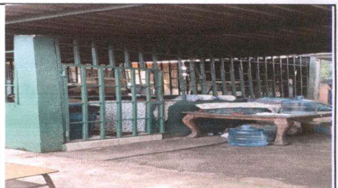
PUERTA Y BARANDA DE COCINA
