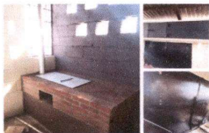
Foto 5: Sustitución de azulejo y mantenimiento de puertas de metal en gabinete de concreto, sustitución de estufa rural completa, aplicación de pintura en cocina
