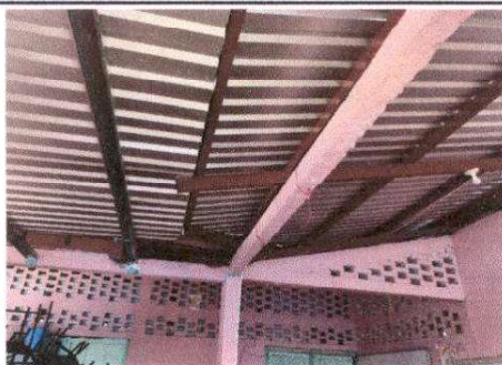
Foto 1: sustitución de estructura de soporte de madera por metal y sustitución de cubierta de lámina en módulo 1 de aulas
