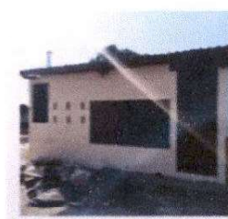
Foto 6: Sustitución de ventana de metal en cocina
