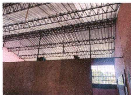
Foto 2: Sustitución de cubierta de lámina en modulo 2 de aulas
