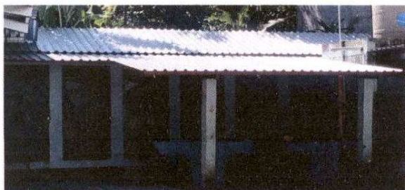
Foto 3: Sustitución de cubierta de lámina y estructura de soporte de metal en servicios sanitarios y área de pila, mantenimiento de puertas de metal y aplicación de pintura en muros
