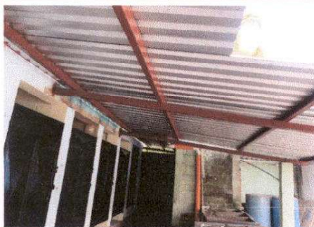
Foto 3: Sustitución de cubierta de lámina y estructura de soporte de metal en servicios sanitarios y área de pila, mantenimiento de puertas de metal y aplicación de pintura en muros
