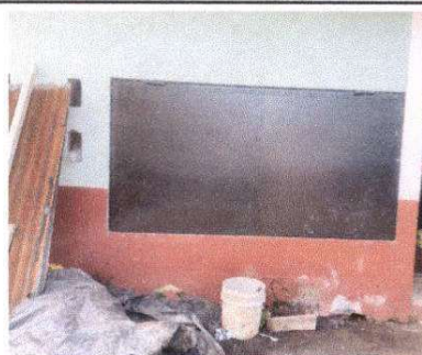
Foto 6: Sustitución de ventana de metal en cocina
