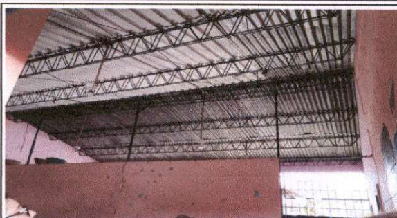
Foto 2: Sustitución de cubierta de lámina en modulo 2 de aulas
