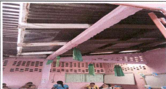
Foto 1: sustitución de estructura de soporte de madera por metal y sustitución de cubierta de lámina en módulo 1 de aulas
