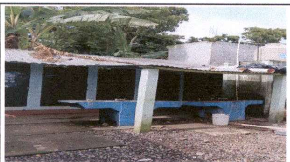
Foto 3: Sustitución de cubierta de lámina y estructura de soporte de metal en servicios sanitarios y área de pila, mantenimiento de puertas de metal y aplicación de pintura en muros
