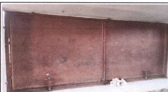
Foto 6: Sustitución de ventana de metal en cocina
