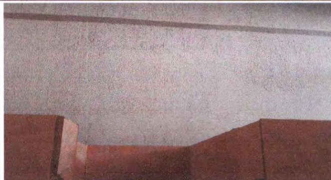
Foto 10: Servicio sanitario. Pintura de paredes.
