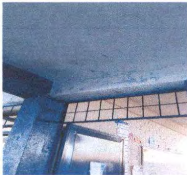
Foto 23: Módulo III. Filtración de agua en corredor.
