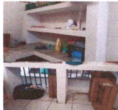
Foto 2: Cocina. Instalación puerta de metal de gabinete.
