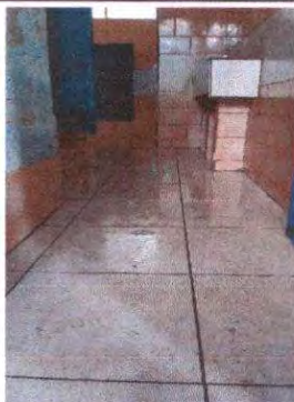
Foto 13: Servicio sanitario. Sustitución de piso.
