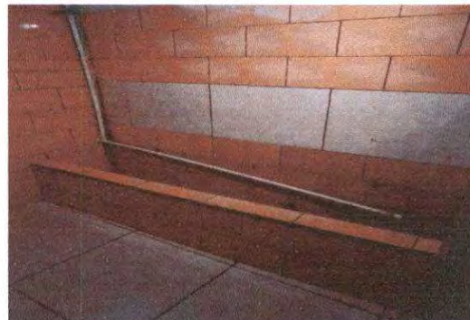
Foto 8: Servicio sanitario. Instalación de tubería para migitorio.
