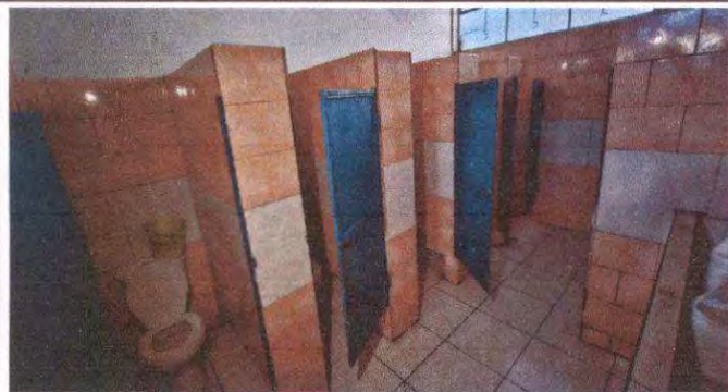
Foto 7: Servicio sanitario. Mantenimiento a puertas de metal.
