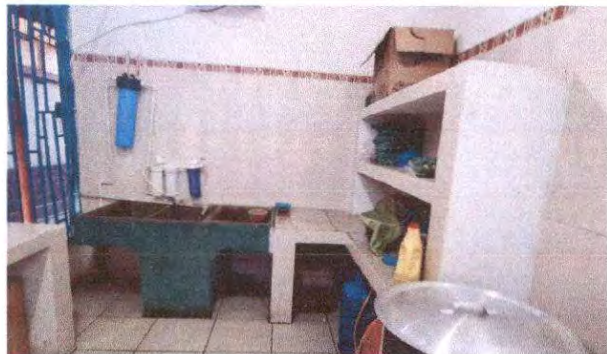
Foto 1: Cocina. Sustrucción de pila de concreto.
