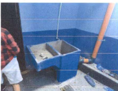
Foto 17: Finalización de sustitución de pila.
