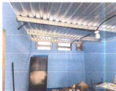
Foto 16: Finalización de sustitución del sistema eléctrico.
