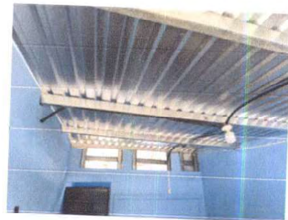
Foto 6: Finalización de pintura, sustitución de techo y estructura metálica en aula cuarto primaria.
