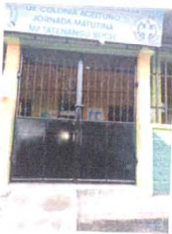
Foto 1: Sustitución de portón de estructura metálica.
