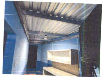
Foto 4: Finalización del gabinete de concreto, pintura, sustitución de techo y estructura metálica.
