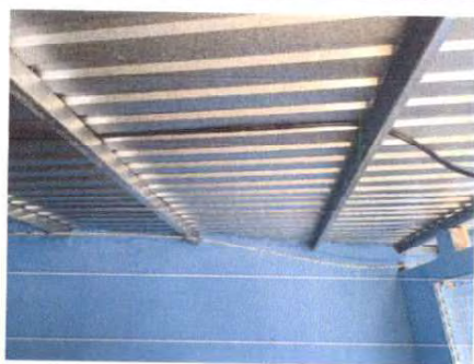
Foto 11: Finalización de sustitución de lámina y estructura metálica.
