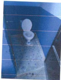
Foto 3: Sustitución de inodoro, sustitución de piso cerámico por piso cerámico y zócalo.
