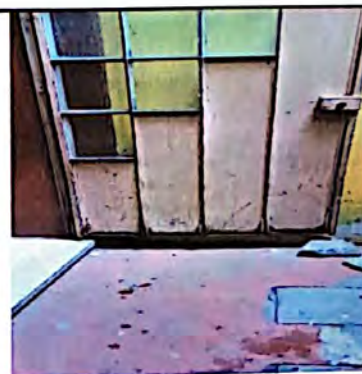
Foto 6: La puerta está oxidada. Necesita ser reemplazada por una nueva. En otras puertas, cambio de chapas.
