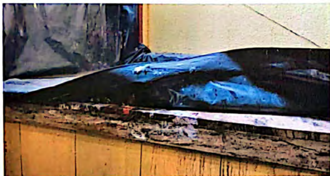
Foto 15: El techo de la bodega de madera se está pudriendo. Se necesita entarimado, anclaje de varilla y fundición con drenaje.
