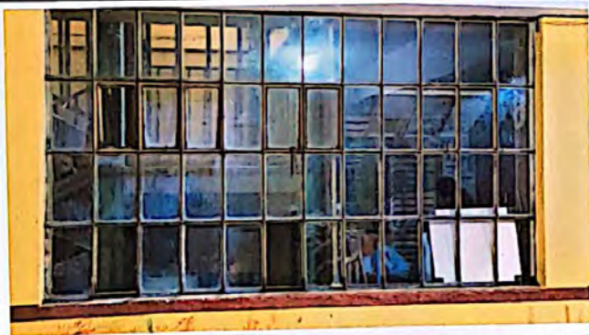
Foto 9: los marcos de metal están oxidadas y vidrios quebrados. Necesita reparación y pintada de marcos y reposición de vidrios.
