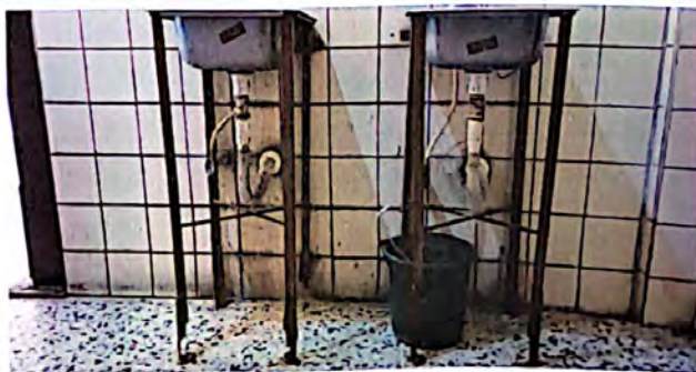
Foto 12: Los lavamanos están en mal estado. Se necesita nuevos lavamanos y fundir repisa de concreto con azulejos.
