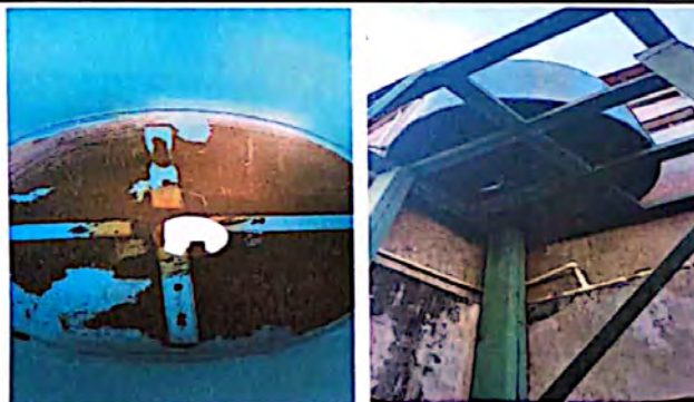
Foto 16: El depósito de agua instalado en el último nivel está roto y las llaves están desgastadas. Se necesita sustitución del mismo.
