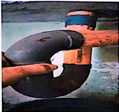
Foto 13: la tubería debajo de la pila está quebrada. Necesita cambio de sifón y válvula de depósito de agua.
