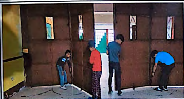
Foto 7: el portón presenta trabas en momento de abrir. Necesita ser reemplazada por una nueva.
