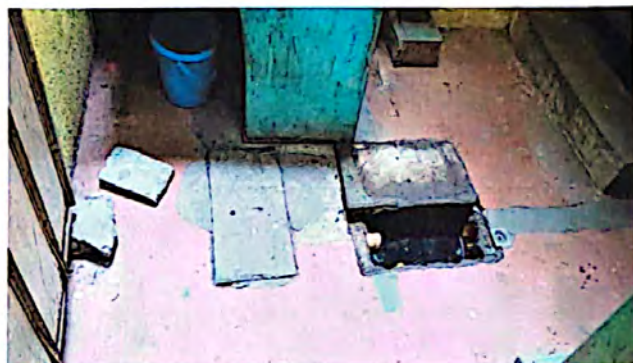
Foto 14: La fosa séptica se encuentra en mal estado. Se necesita limpieza y cambio de tubería.
