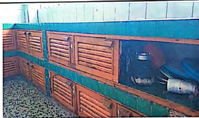
Foto 4: las puertas de madera para la alacena están flojas, se traban las llaves y en algunas se caen solas. Se necesitan sustituirlas por nuevas puertas de metal.
