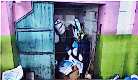
Foto 3: Instalación de puerta de bodega.
