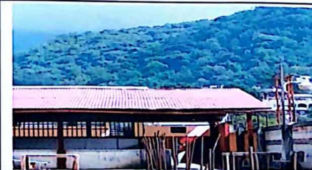
Foto: Falta de instalacion electrica en el segundo nivel
