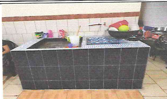
Construcción de lavadero de concreto,
