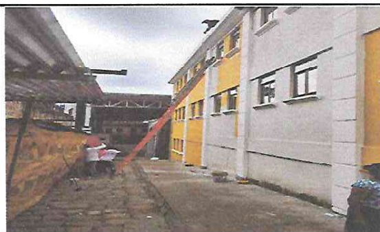
Pintada parte exterior de la escuela
