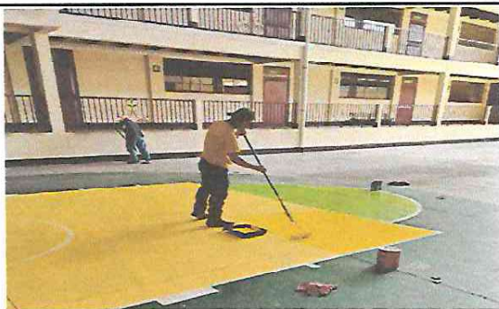
Pintada de la cancha deportiva
