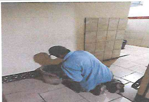
Colocación de azulejos en el sanitario de varones primer nivel
