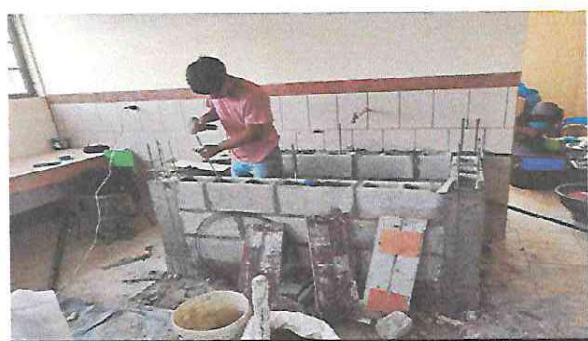
Construcción de lavadero de concreto,
