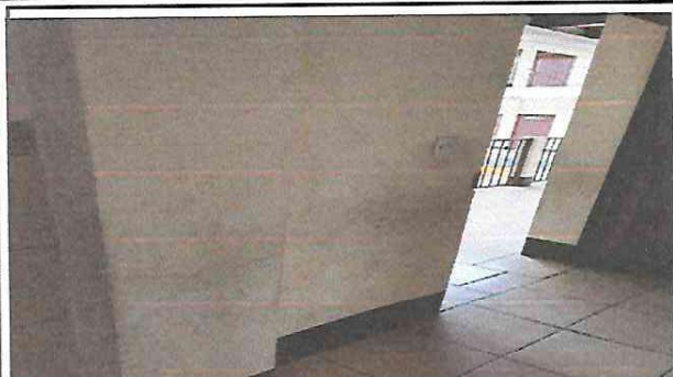
Colocación de azulejos en el sanitario de varones primer nivel
