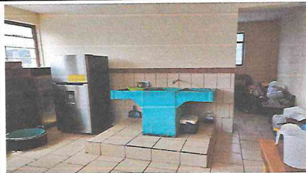
Construcción de lavadero de concreto,
