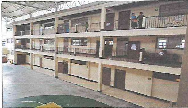
Mantenimiento de barnada de metal
