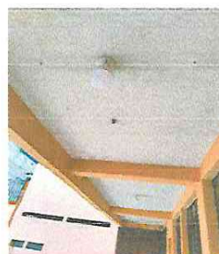
Reparación de sistema eléctrico
