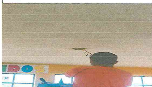
Foto 6: Reparación del sistema Eléctrico
