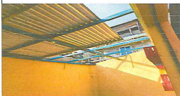
Foto 1: Cubierta de Lámina
