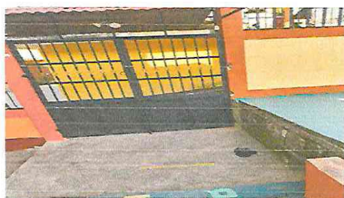
Foto 5: Mantenimiento a Portones
