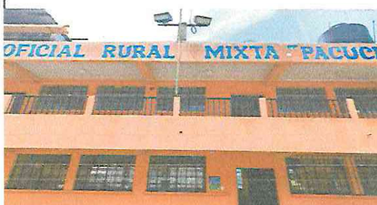
Foto 4: Mantenimiento de Barandas
