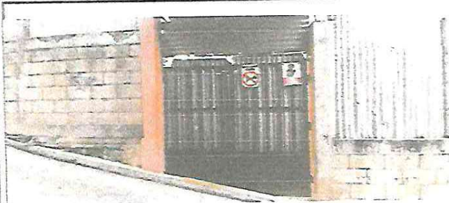
Reparación a portones
