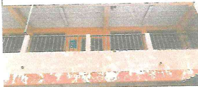
Mantenimiento de baranda
