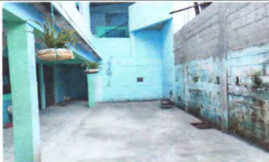
Foto 1: Terminación pavimento de patio
