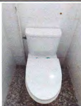
Foto 3: Instalación de sanitario
