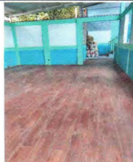
Foto 2: Colocación de Piso Ceramica en el Salón de usos multiples
