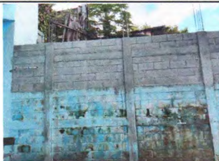
Foto 6: Terminación de muro perimetral
