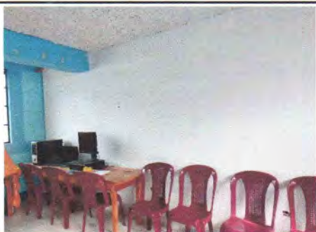
Foto 5: Levantado de pared en el laboratorio de computación
