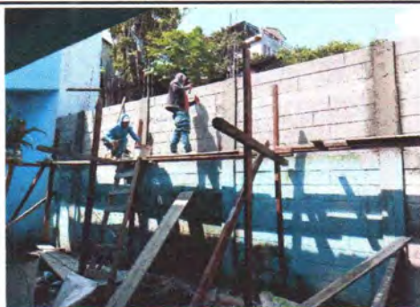
Foto 3. Levantado de muro de block
