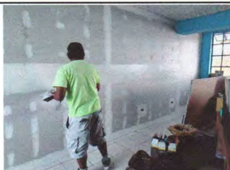
Foto 4. Levantado de pared de tabla yeso
