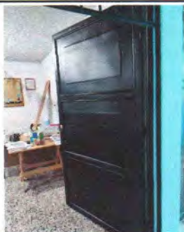
Foto 5. Colocación de puerta de metal
