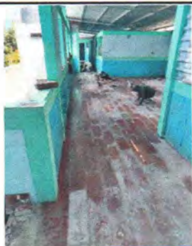
Foto 1. Colocación de piso cerámico
