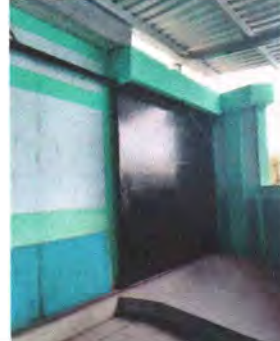
Foto 8. Mantenimiento y reparación de portón
