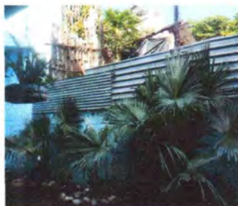
Foto 5. Sustitución pared de lámina a pared de block
