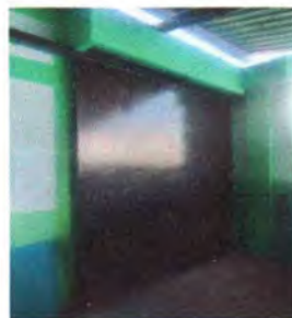
Foto 4. Mantenimiento de portón de entrada
