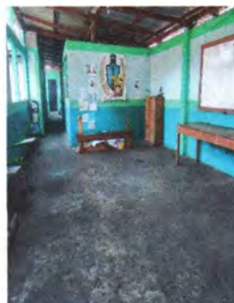
Foto 2. Instalar piso de cerámico en el salón de usos múltiples.
