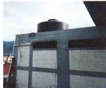
Foto 8. Sustitución depósito de agua
