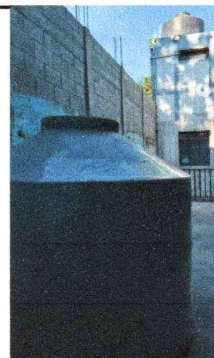
FOTO 6: 18. Reparación de un depósito de agua y compra de un depósito nuevo.
