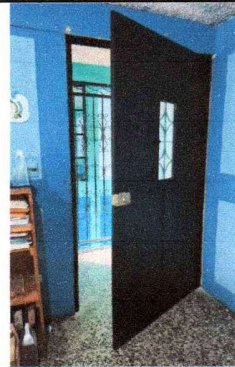
FOTO 2: 4. Sustitución de puerta de madera por puerta de metal
