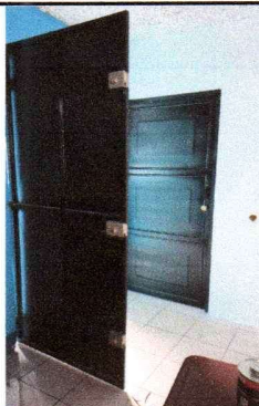
FOTO 3: 4. Sustitución de tres chapas en puerta de metal.
