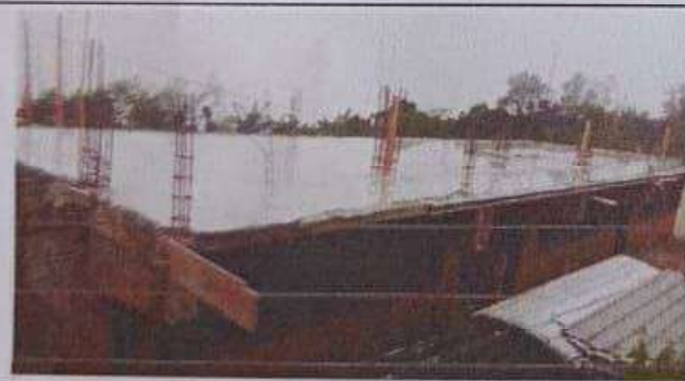
Foto 5: Vista general del techo
