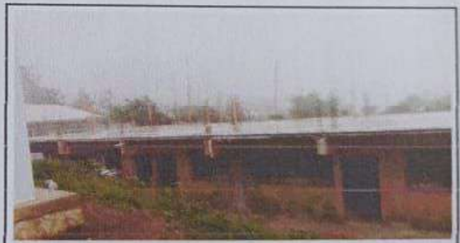
Foto 6: Vista frontal de las tres aulas
