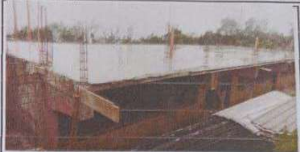
Foto 2: Vista del techo
