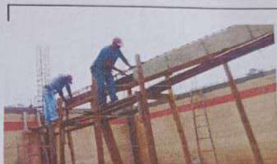
Foto 4: amarre de vigas de las aulas
