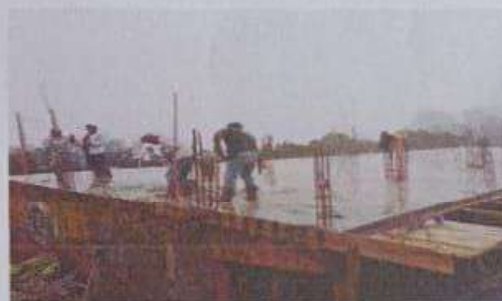
Foto 6: terminacion del cambio de estructura del techo
