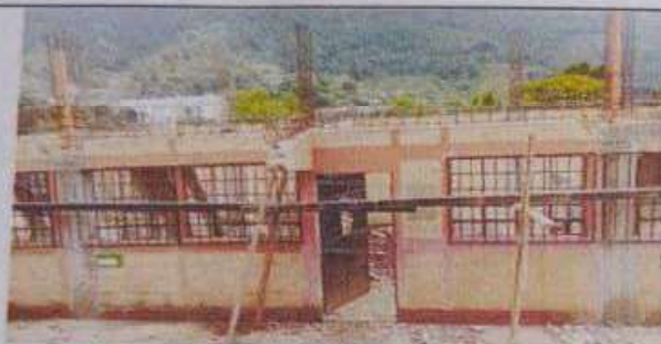
Foto 3: fundicion de calomunas del establecimiento
