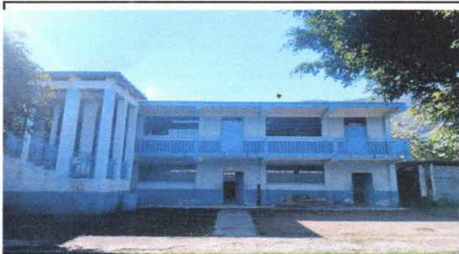
Reparación de baranda segundo nivel.
