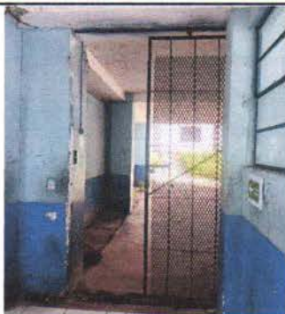
Sustitución de puerta principal del primer nivel.
