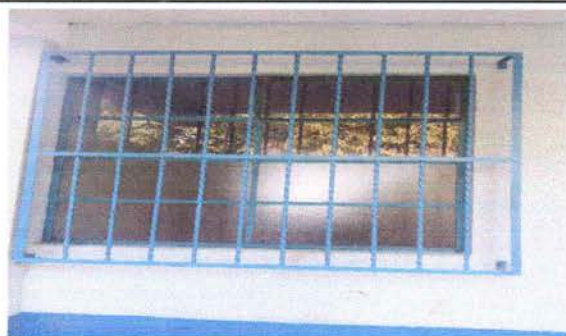
Barandas de los servicios sanitarios
