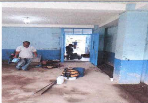
Sustitución de puerta principal del primer nivel.
