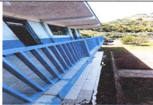
Reparación y mantenimiento de baranda, cambio de barotes, lijar, fondear y pintar.
