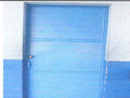
Reparación y mantenimiento de puertas, lijar, fondear y pintar.
