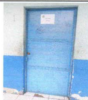
Reparación y mantenimiento de puertas, lijar, fondear y pintar.
