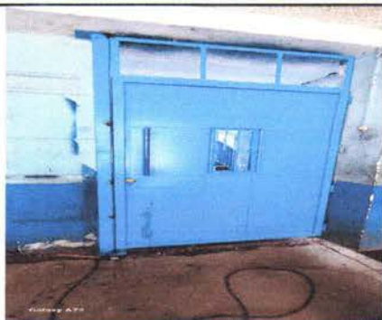
Sustitución de puerta principal del primer nivel.
