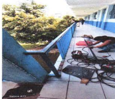
Reparación y mantenimiento de baranda, cambio de barros, lijar, fondear y pintar.
