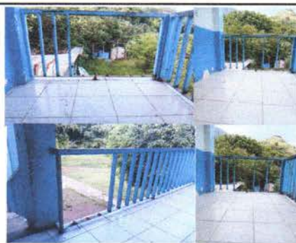
Reparación y mantenimiento de baranda, cambio de barrotes, lijar, fondear y pintar.
