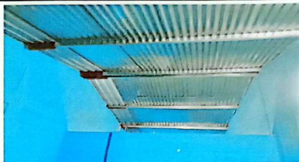
Foto 2: Culminación del muro perimetral, para la seguridad del Centro educativo.
