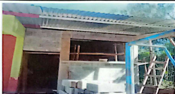
Foto 1: Culminación de la sustitución de láminas de la EORM, Sector II, Caserio Panacal, Aldea Panyebar.
