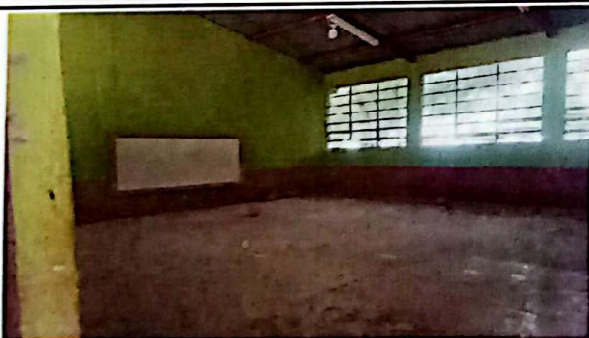
Foto 5: Preparación del aula para la sustitución del piso del establecimiento.
