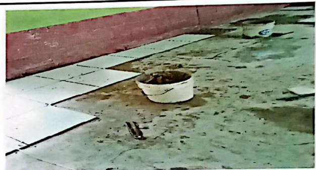
Foto 4: Colocación de piso en el corredor del Centro educativo.
