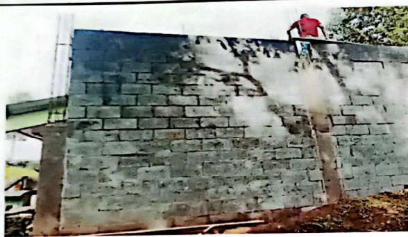
Foto 3: Construcción del muro perimetral, para la seguridad del Centro educativo.
