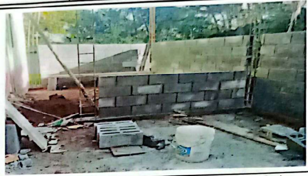
Foto 2: Construcción del muro perimetral para la seguridad del Centro educativo.
