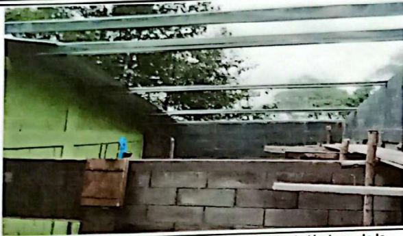
Foto 1: Colocación de costaneras para la sustitución de láminas, de la EORM, Sector II, Caserio Panacal, Aldea Panyebar.
