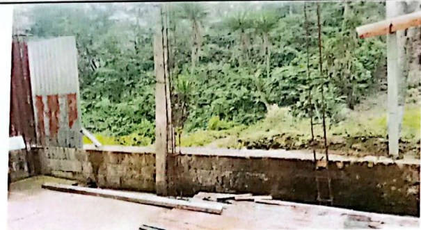
Espacio donde se realizará el muro perimetral, para la seguridad del Centro educativo.
