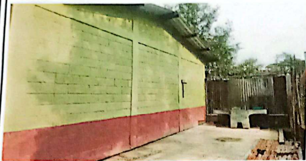
Espacio donde se realizará la sustitución de láminas, de la EORM, sector II, caserio Panacal, Aldea Panyebar.
