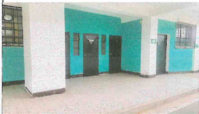
Mantenimiento y reparación de puertas de metal
