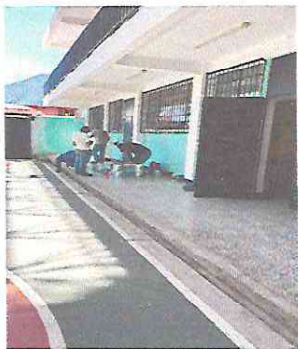
Foto 1: Inicio de la pintada de paredes y cambio de chapas
