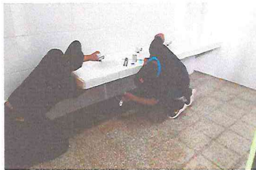
Foto 2: sustitucion de grifos
