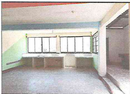
FOTO 5: LAVATRASTE, LAVADERO Y MAS COMPONENTES DE LA COCINA, PARA FACILITAR EL TRABAJO DE LAS COCINERAS.
