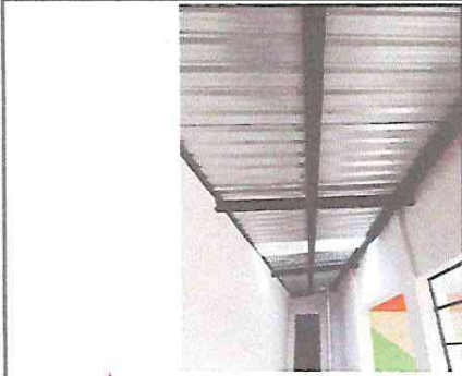
FOTO 1: SE OBSERVA EL TECHO TERMINADO.
