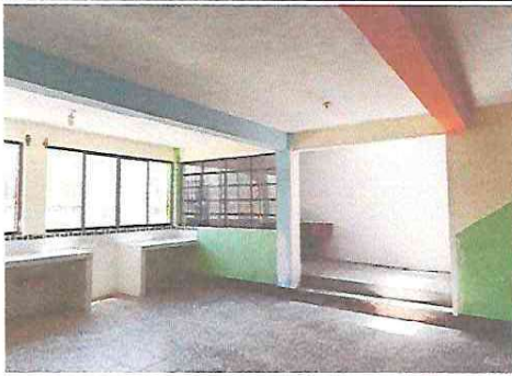
FOTO 3: PISO Y AMPLIO ESPACIO DE LA COCINA.
