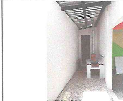
FOTO 2: ESTRUCTURA METÁLICA Y TECHO FINALIZADO.
