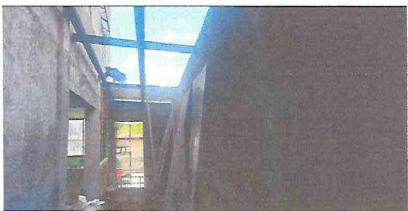
FOTO 1: ES LA PARTE QUE SE LE AGREGARÁ A LA COCINA, Y ES NECESARIO CUBRIRLO CON LÁMINAS.
