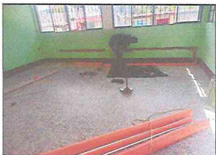
FOTO 5: SE OBSERVA EL TRABAJO PARA LA INSTALACIÓN DE LA TUBERÍA DE LAVATRASTE Y OTROS.
