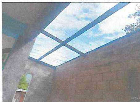
FOTO 2. PARA TECHARLO SE REQUIERE DE LA ESTRUCTURA METÁLICA QUE AQUÍ SE OBSERVA.
