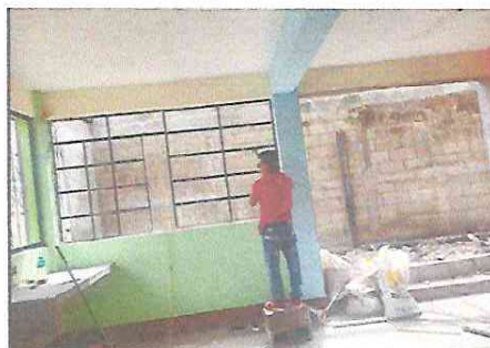
FOTO 4: DESPUES DE UNOS TRABAJOS EN ROMPER LA PARED, SE OBSERVA LA AMPLITUD DEL ESPACIO PARA LA COCINA.
