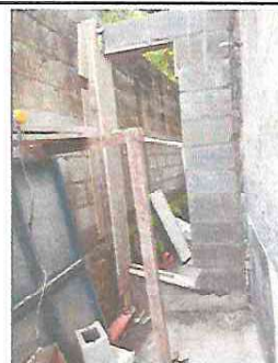
FOTO 6: SE OBSERVA EL MURO DE CONTENCIÓN PARA LA SEGURIDAD DE LA COCINA.
