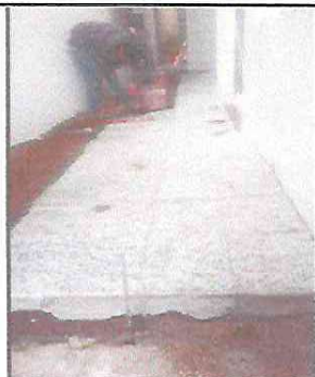
FOTO 3: SE ESTÁ AVANZANDO EN LA COLOCACIÓN DE PISO.
