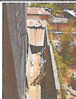
FOTO 6. Este es el muro que se arreglará que está entre la escuela y una propiedad privada, el muro es de la escuela, se elevará mas para tener una altura aceptable para protección de la cocina.
