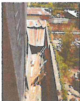
FOTO 1. Es el espacio que se va a cubrir de láminas para ampliar la cocina
