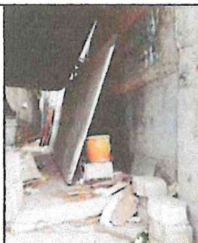
FOTO 3. Espacio donde se colocará piso.
