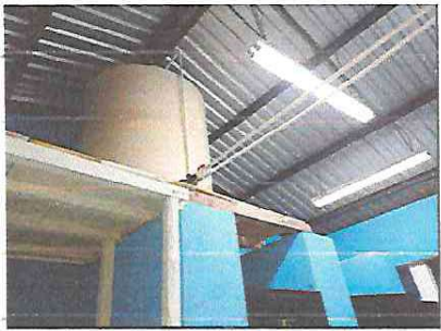
FOTO 5: INSTALACIÓN Y CULMINACIÓN DEL ROTOPLAS CON TODAS LAS TUBERÍAS NECESARIA.
