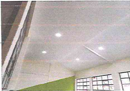
FOTO 1: TECHO FALSO E ILUMINACIÓN FINALIZADA EN ESTE SALÓN QUE CORRESPONDE A PRIMERO BÁSICO.
