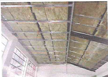
FOTO 1: Se observa el trabajo que se está realizando para el techo falso y su respectiva iluminación.
