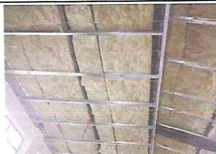
FOTO 4: En esta fotografía se observa el trabajo para techo falso.. Son tres salones que se tienen que colocar techo falso.
