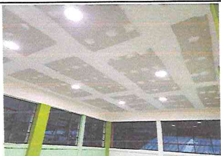
FOTO 3: En esta evidencia se observa que la iluminación y techo falso, esta en avance.
