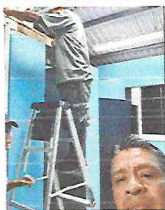
FOTO 5: Se observa el trabajo para la colocación del rotoplas.
