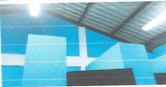
FOTO 5; EN ESTOS BAÑOS SE COLOCARÁ UN TINACO EN EL CUAL PARA EL DEPÓSITO DE AGUA RESPECTIVO
