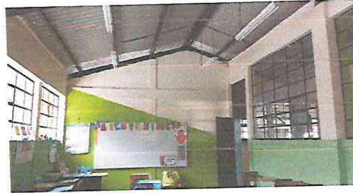
FOTO 2 En este salón de segundo básico se construirá un techo falso con material tabla yeso.
