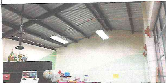
FOTO 4: En este salón se construirá un techo falso con material tabla yeso con su respectiva iluminación
