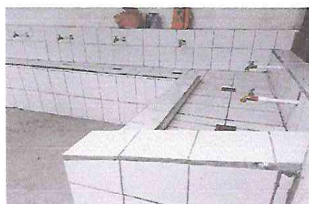
REPARACION O SUSTITUCION DE AZULEJOS
