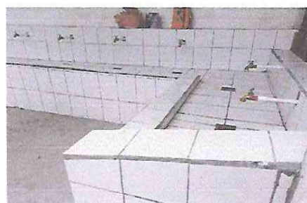
REPARACION O SUSTITUCION DE AZULEJOS
