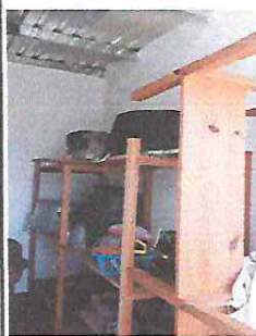
CUBIERTO DE LAMINA
