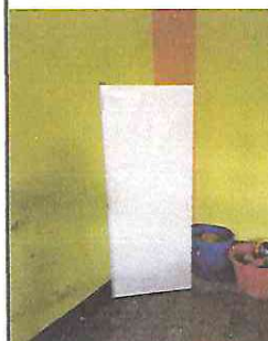
PUERTA DE METAL
