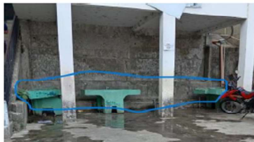
REPARACION O SUSTITUCION DE AZULEJOS
