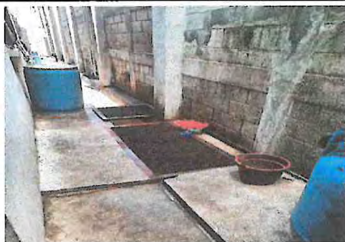
Foto 9: Colocación de pila de dos alas.
