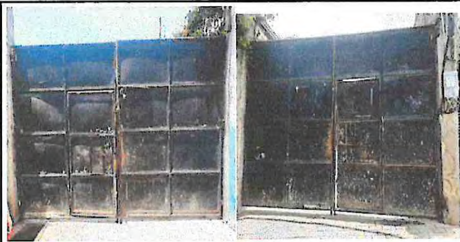
Foto 7: Mantenimiento del porton de metal de la entrada principal de la escuela, pinta interior y exterior.
