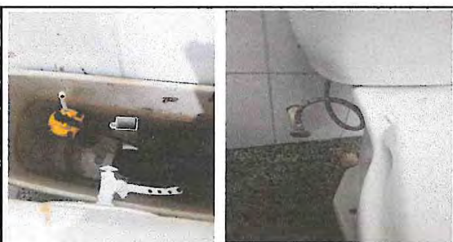
Foto 5: Mantenimiento de servicios y accesorios de sanitarios de módulo No. 1.
