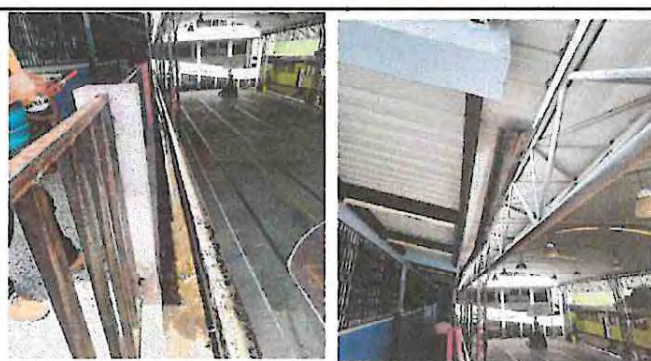
Foto 4: Reparación de caneleta para bajada de agua pluvial.
