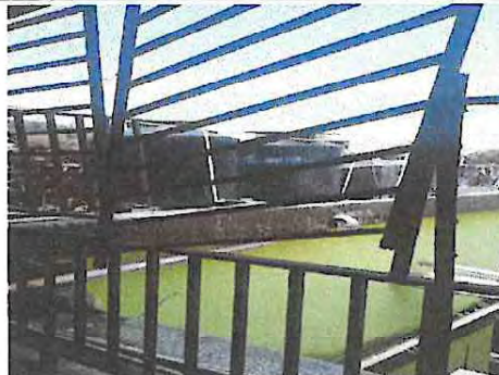
Foto 10: Reparación y accesorio de depósito de agua.
