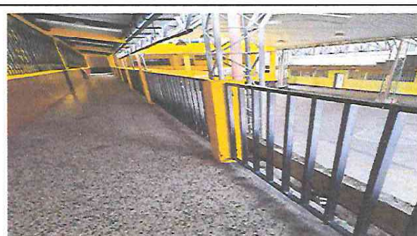
Foto 6: Pintada 9 barandas del módulo No. 1 en color negro.
