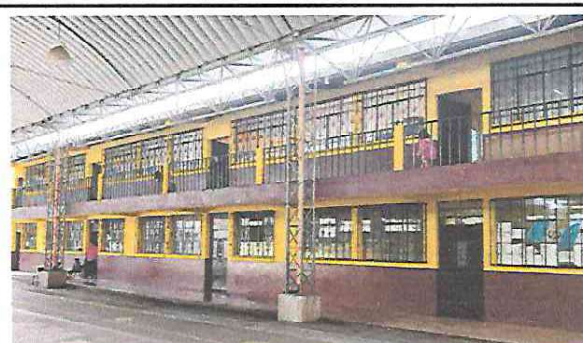
Foto 2: Pintada del módulo #01 del nivel preprimaria del primer y segundo nivel
