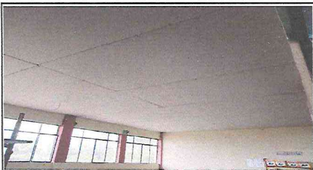
Foto 1: Techado de cielo falso por unmento de calor en temporadas de invierno de 4 salones de clases
