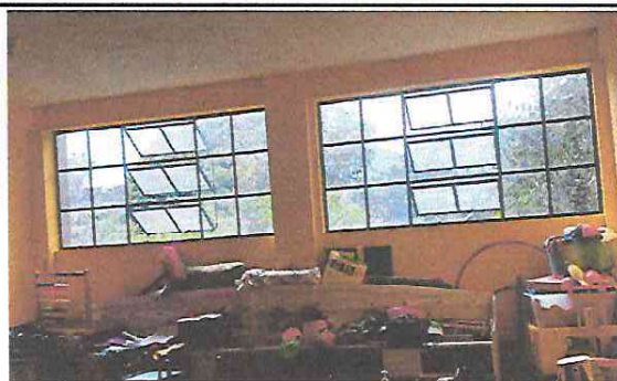
Foto 3: Apertura de dos ventanas en interior del salon de preprimaria por falta de luz natural.
