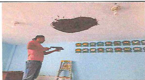
Foto 11: Reparación de repello.
