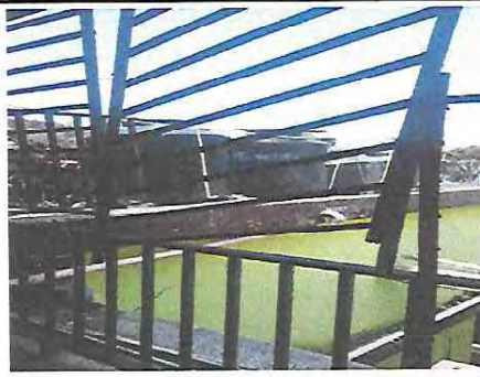
Foto 10: Reparación y accesorio de depósito de agua.
