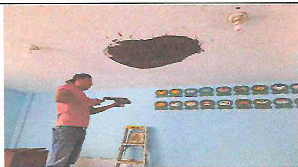
Foto 11: Reparación de repello.
