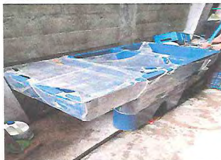
Foto 9: Colocación de pila de dos alas.
