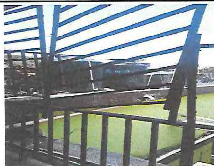
Foto 10: Reparación y accesorio de depósito de agua.
