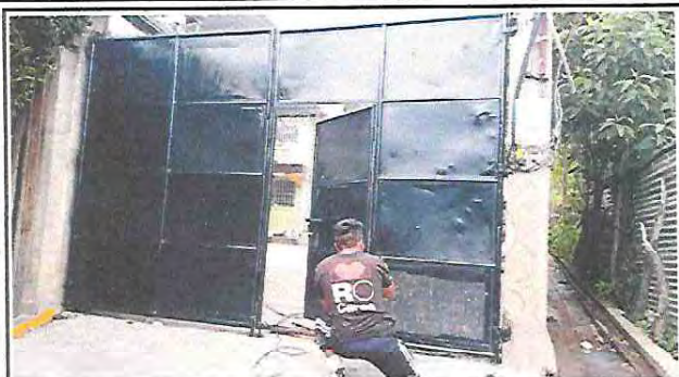
Foto 7: Mantenimiento del porton de metal de la entrada principal de la escuela, pinta interior y exterior.
