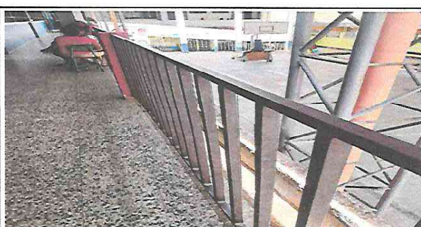
Foto 6: Pintada 9 barandas del módulo No. 1 en color negro.
