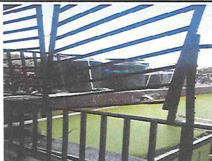
Foto 10: Reparación y accesorio de depósito de agua.
