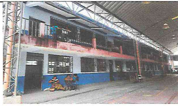
Foto 2: Pintada del módulo #01 del nivel preprimaria del primer y segundo nivel
