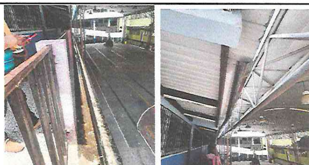
Foto 4: Reparación de cancheta para bajada de agua pluvial.
