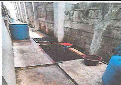
Foto 9: Colocación de pila de dos alas.
