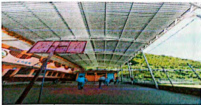
Foto 11: INSTALACIÓN DE TIJERAS Y VIGAS DE METAL EN PATIO.
