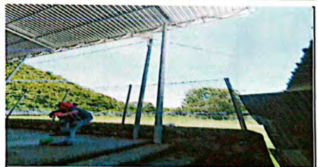
Foto 12: INSTALACIÓN DE JOIS PARA ESTRUCTURA DE TECHO
