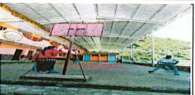
Foto 6: INSTALACIÓN DE ESTRUCTURA METALICA CON COSTANERAS.
