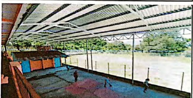
Foto 4: INSTALACIÓN DE TIJERA PARA ESTRUCTURA METALICA
