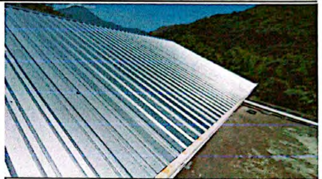
Foto 8: VISTA LATERAL DE ESTRUCTURA PARA TECHO
