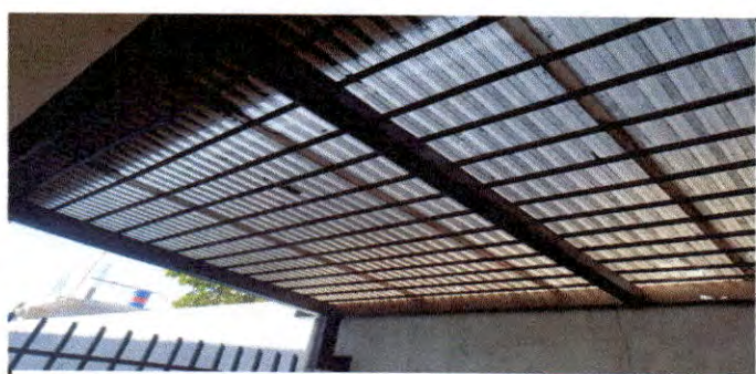
Foto 12: LAMINA DE MÓDULO ROTA
