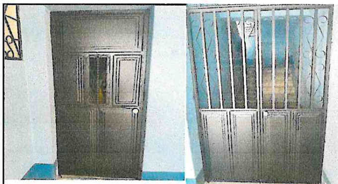
Foto 3. Puerta del aula de Educación Física colocada y puerta de emergencia instalada.
