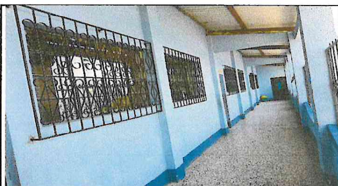
Foto 4. Balcones instalados en segundo y tercer nivel.
