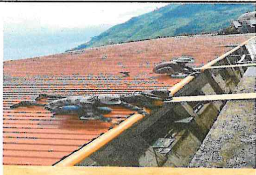
Foto 1. Se terminó de colar los tubos para recepción de las aguas pluviales.
