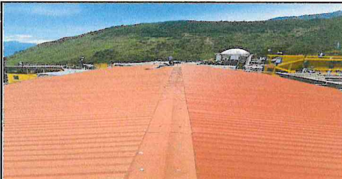
Foto 2. Techo totalmente renovado finalizando con la colocación de las láminas para protección de los niños de la lluvia.
